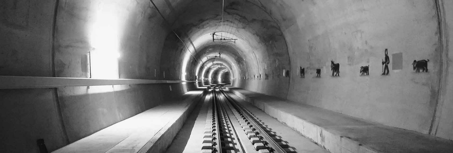
Modern, sauber und mit Alpaufzug. Der Ruckhaldentunnel.
